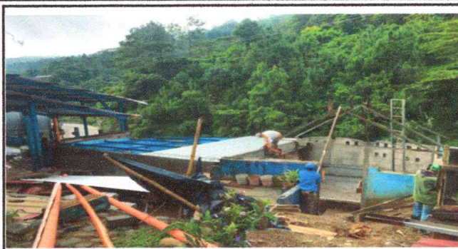
Foto 2: Trabajos en espacios contiguos del módulo 2: colocación de lámina troquelada calibre 26 en el aula y albañilería en el área de cocina.
