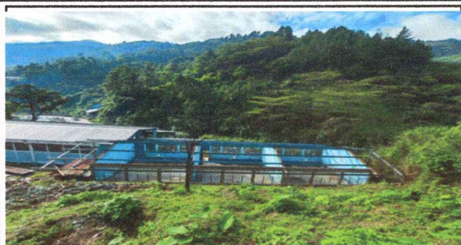
Foto 1: Desmantelación de láminas de zinc oxidadas en el módulo 1 para su sustitución con lámina troquelada calibre 26.
