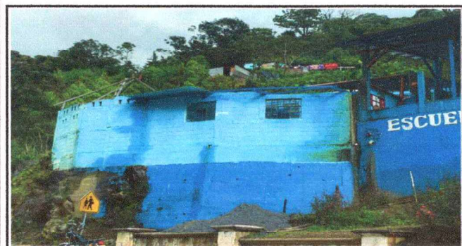
Foto 3: Parte frontal del modulo 2 donde se ejecutan trabajos de los renglones de cubierta de lamina y estructura de techo.
