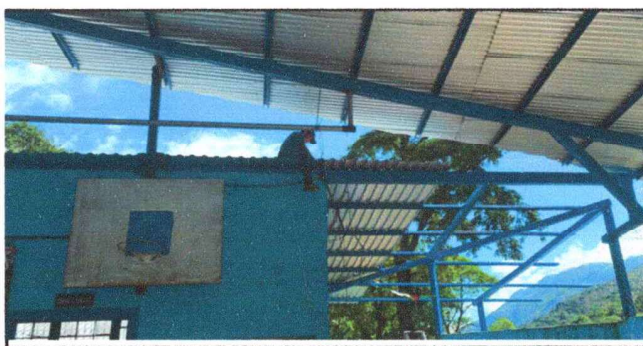
Foto 6: Vista desde el interior con la instalación de lámina troquelada calibre 26 y ampliación de colocación de estructura de techo en el módulo 3.
