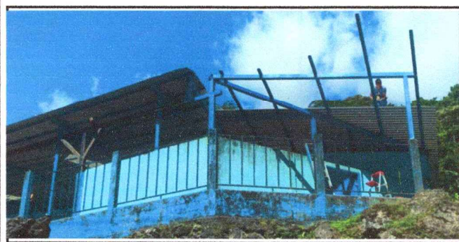
Foto 5: Ejecución de trabajos en renglones de cubierta de lámina y estructura de techo en la entrada del edificio escolar.
